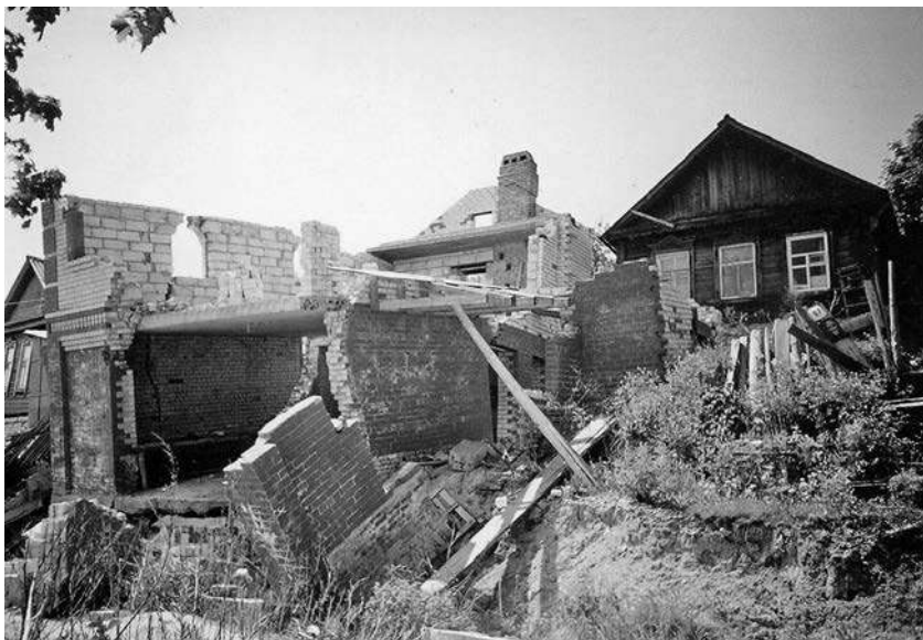
Рис. 2.2. Разрушительные последствия нелинейного катастрофического оползневого процесса, спровоцированного как природными, так и антропогенными причинами (г. Саратов, фото А.В. Иванова)
