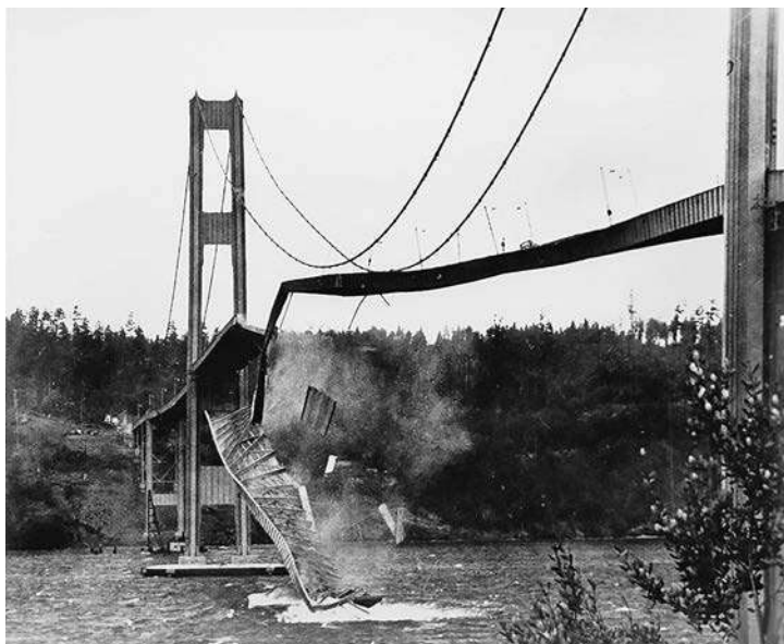
Рис. 2.32. Разрушение Такомакского моста в 1940 г. — пример техногенной катастрофы бифуркационного типа вследствие недоучета нелинейности эффектов при взаимодействии потоков воздуха и инженерных сооружений ( http://mgssupgs.livejournal.com/465911.html )
